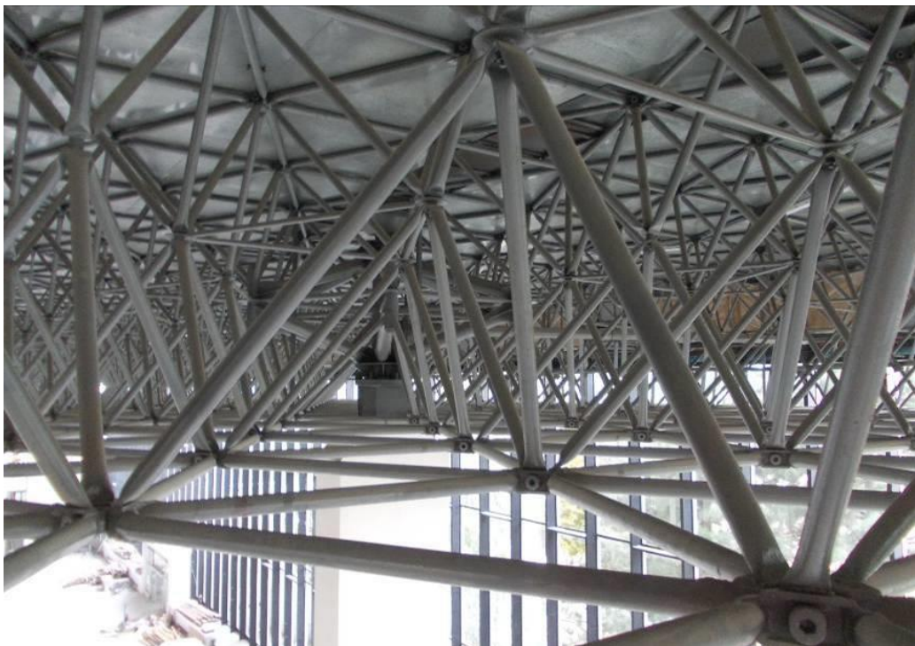
Obrázek 2.: Prostorový systém střešní příhradové konstrukce objektu
