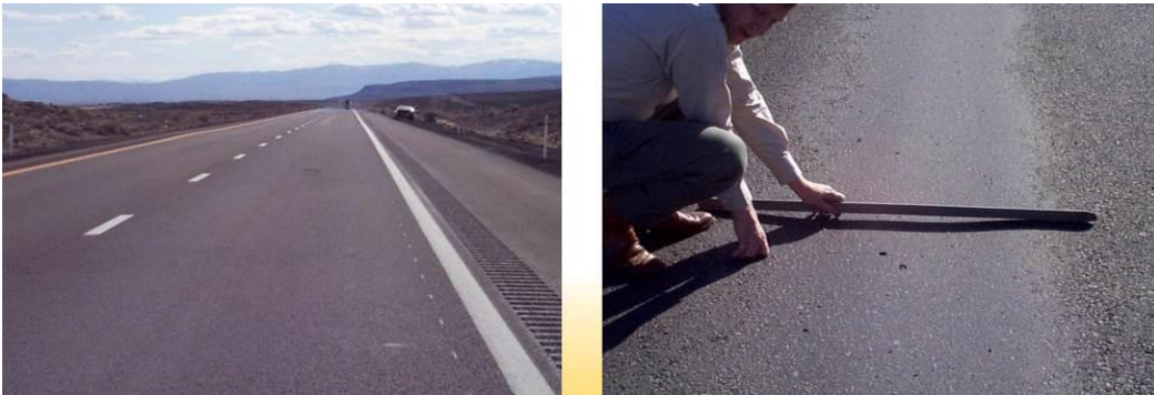
Obrázek 1.: Trvalé deformace při použití rozdílných asfaltových pojiv [6]
