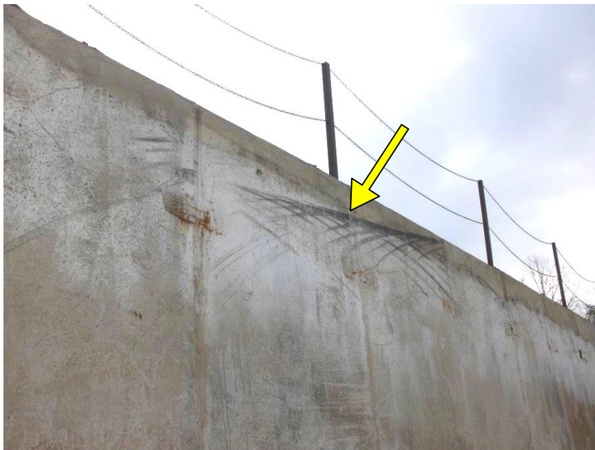
Obr. 7.: Otěry pneumatik (šipka) od nárazů kolového nakladače, poježdějícího po skladovaném materiálu
