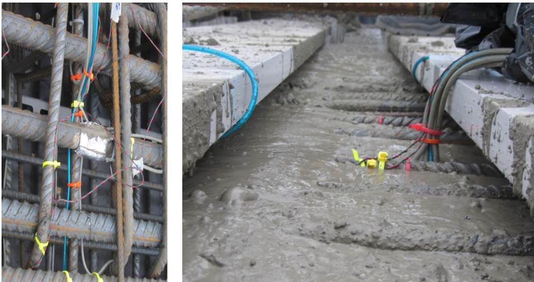
Obrázek 4 – vybavení tenzometrů v konstrukci, zajištění vývodů při betonáži
